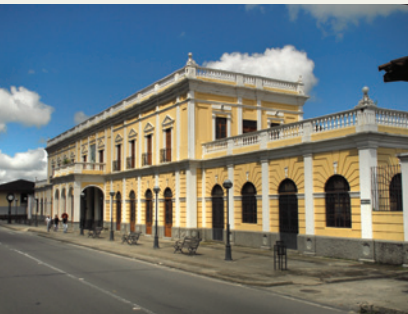
Antigua estación del ferrocarril
